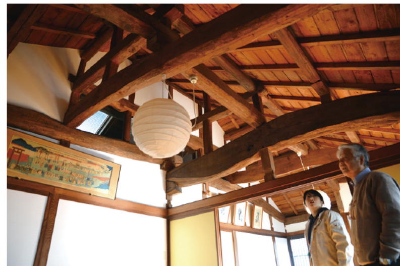
2階は天井を抜き、屋根組みを見せることで空間が広がり、木の風合いが強調される。
