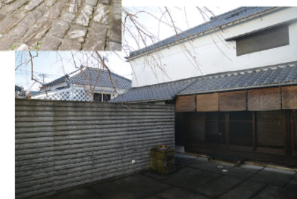
中庭を新しくコンクリート壁で囲み、土面をコンクリート打ちすることでメンテナンスを楽にした。
