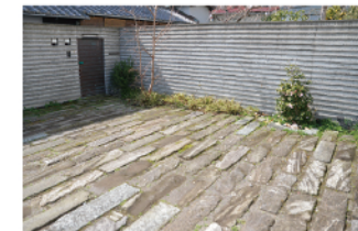
伊豆石を敷石として利用した駐車場。
